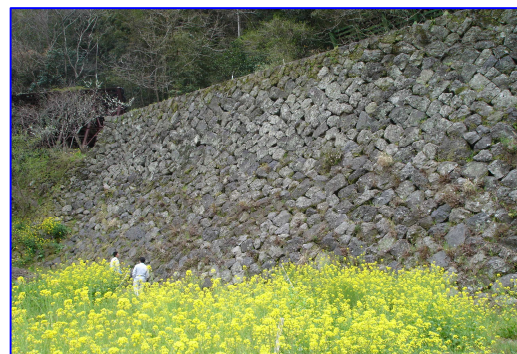
写真 27 石垣の村 高さ 11m の石垣を有する棚田
