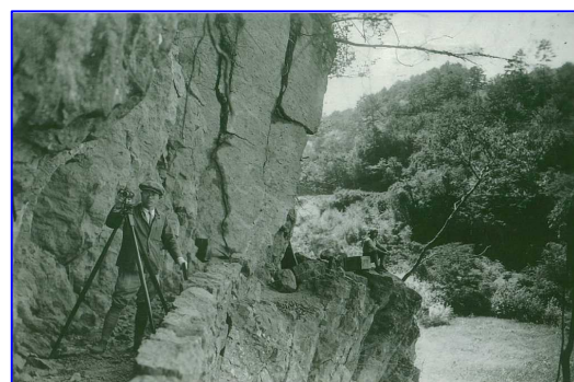
写真 28 本地域の山腹水路建設時の測量
