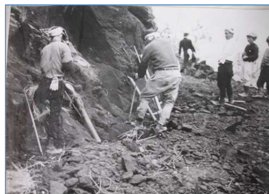
写真 29 本地域の山腹水路の建設作業 (出典：水土里デジタルアーカイブス)
